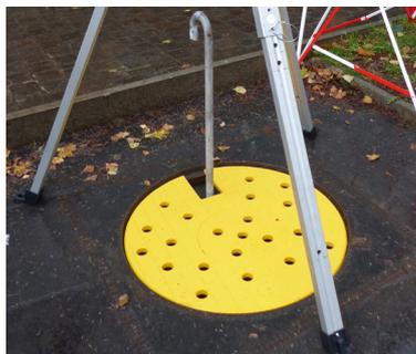
Il chiusino è una piastra che si inserisce temporaneamente su un tombino. È costituito da una lastra polimerica ad alta densità che presenta proprietà di resistenza al carico e durevole nel tempo.
